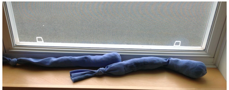
Figure 2: Serpents anti-courant d'air bloquant les courants d'air, Écoles Vertes N.-É.
